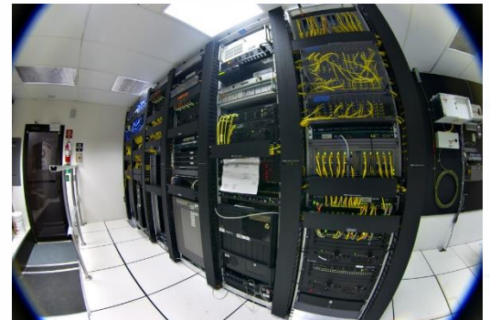
Figura 2 - Cabeamento estruturado (Datacenter). Fonte: https://pt.wikipedia.org/wiki/Cabeamento_estruturado (Acesso em 09/08/2017)
