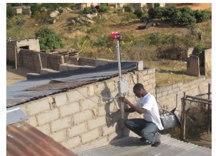
Figura 1 - Instalação de rede wireless em zona rural. Fonte: https://commons.wikimedia.org/wiki/File:Building_a_rural_wireless_mesh_network.png (Acesso em 09/08/2017)
